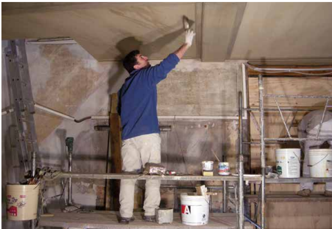
Le fasi del restauro ligneo della cantoria.
