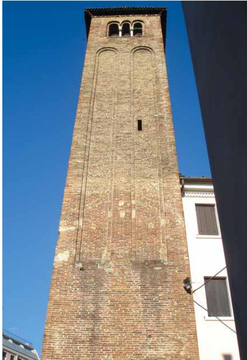
Il campanile dopo l'intervento di restauro.
