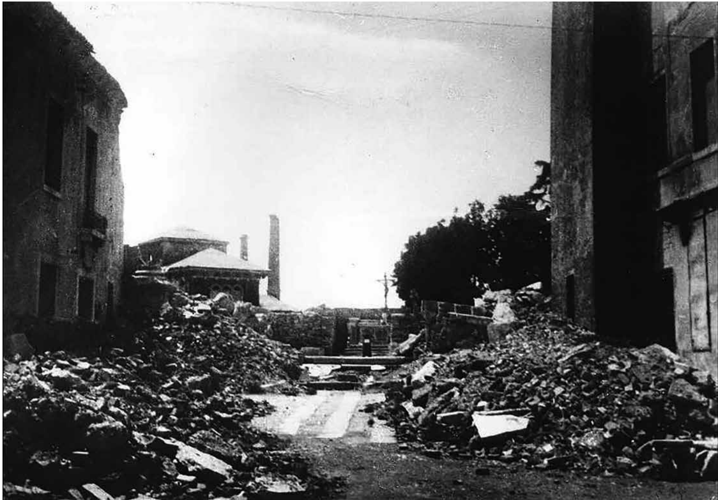
La chiesa di San Martino rasa al suolo dopo il bombardamento del 7 aprile 1944.
